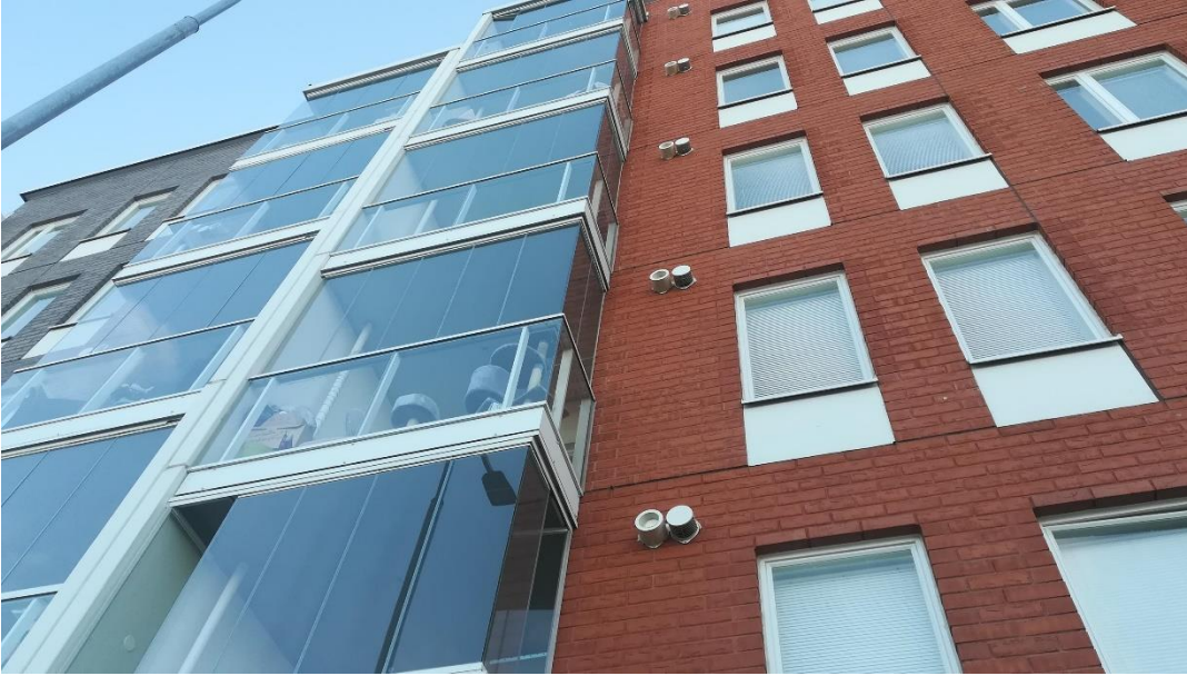
Kuva 1. Yleiskuva julkisivusta ja parvekkeista. Tuloilman ottoaukot parvekkeiden vieressä.
