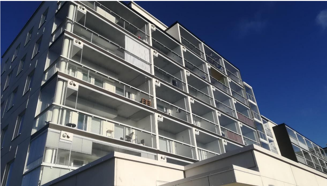
Kuva 2. Yleiskuva julkisivusta ja parvekkeista. Tuloilman ottoaukot parvekelinjalla.
